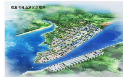
威海港乳山港区工程 Weihai Port Rushan Harbor District Project
