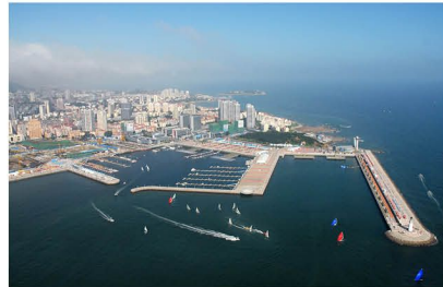
青岛国际帆船中心 Qingdao International Sailing Center
