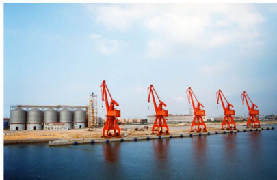
山东龙口市 5 万吨级粮食码头主体工程 Shandong Longkou 50-thousand-ton Grain Dock Project
